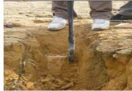
الطريقة اليدوية لعمل حفرة الاختبار
